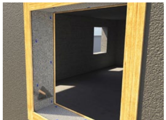
Trykk lekt i murmørtel rundt åpninger for å støtte rettingen av smyger.
