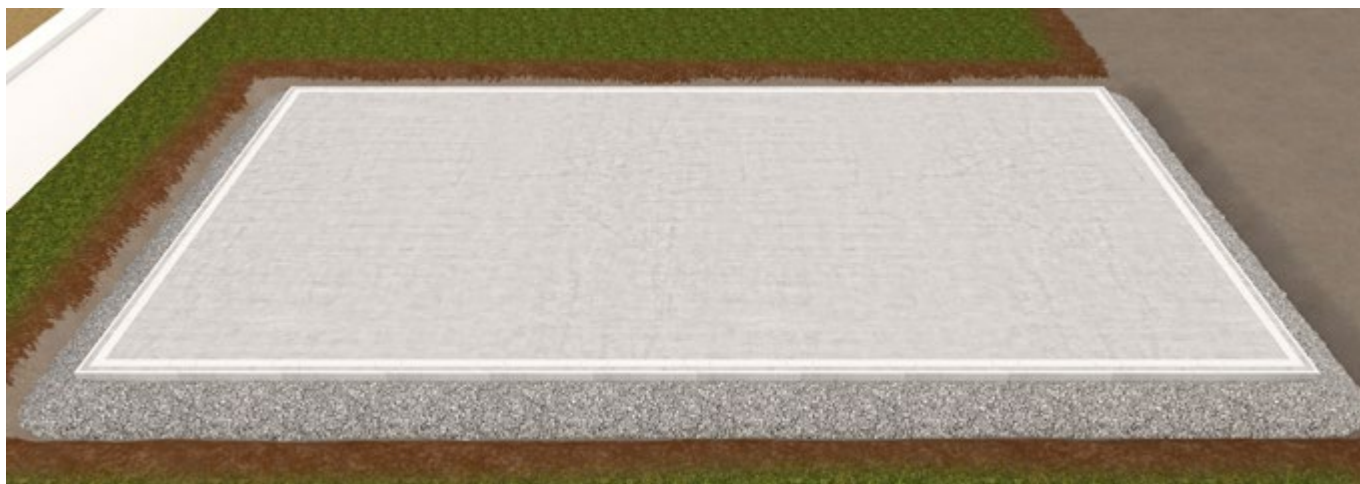
Nå er grunnlaget komplett!
