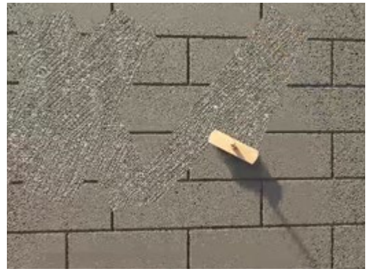
For å sikre at hele veggen er dekket av Grunningsmørtel A, børster du overflaten med en kalkbørste.
