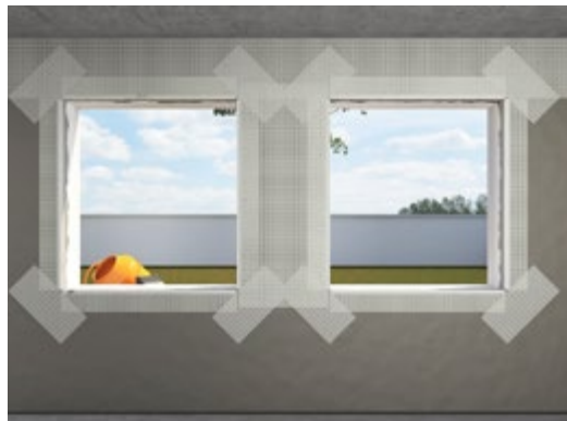
Installer glassfibervinkler og legg nett diagonalt rundt alle hjørner som før.
