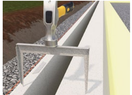
Fest en festekil per skjøt i overkant mellom hvert element.
