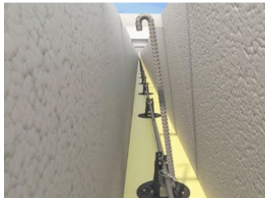
Bøyle 2 holder de to langsgående armeringsjernene sammen i den ytre betongbjelken.
