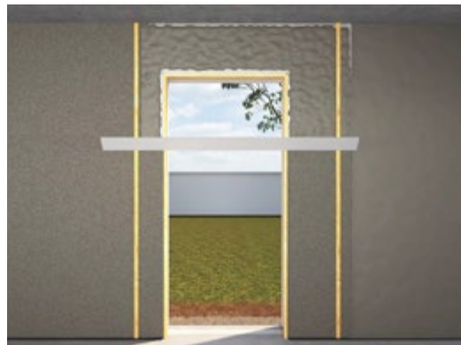
Puss innvendigt med avtrekksbaner på samme måtet som utvendigt.
